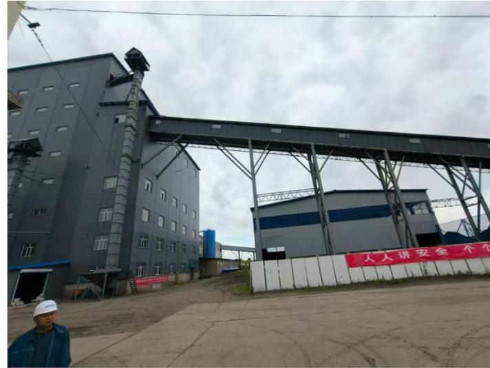
封闭式输煤栈桥（一）
